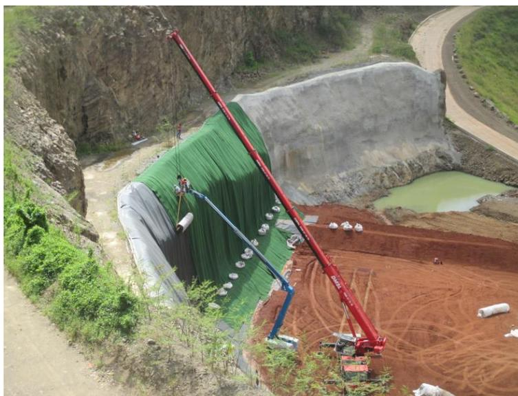
Figure 7. Méthodologie de mise en œuvre par déroulage en partant du haut de talus.
