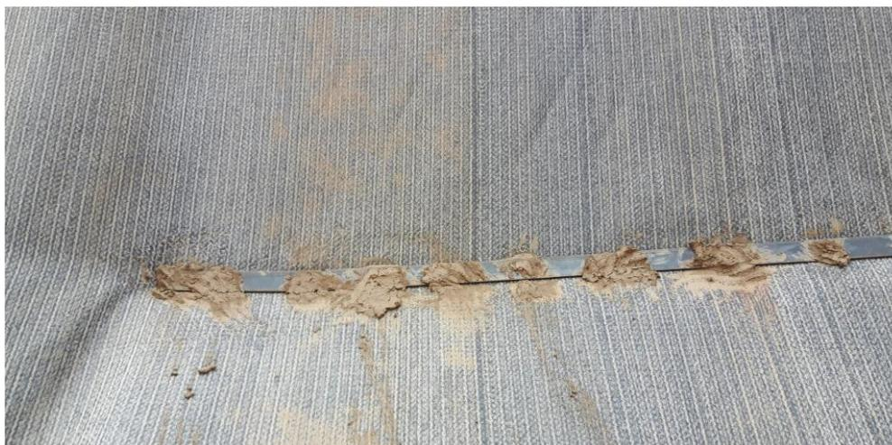
Figure 8. Détail de pâte bentonitique au niveau des ancrages intermédiaires.
