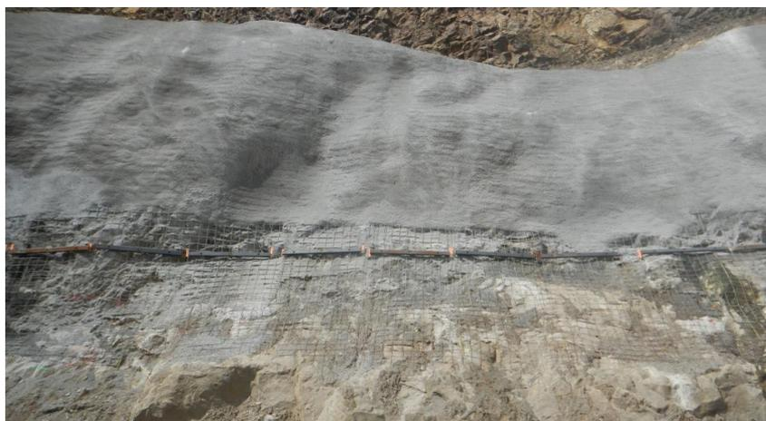
Figure 5. Profilés métalliques dans le parement pour ancrage du GSB.
